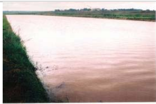
Figure 23 : Night storage reservoir (SUCOMO)
