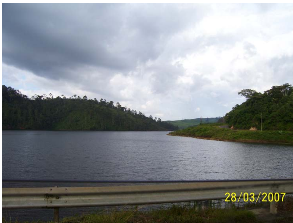
Photo 1. Réservoir de la Rwegura
